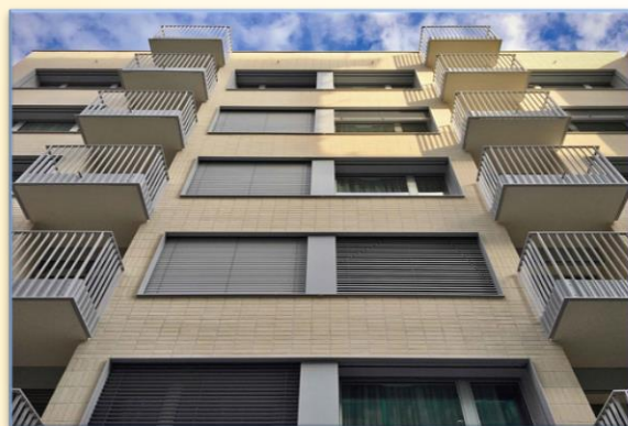
Projet de rénovation et d'assainissement des façades d'un immeuble d'habitation à Genève Mètres - Soumissions Année 2020
