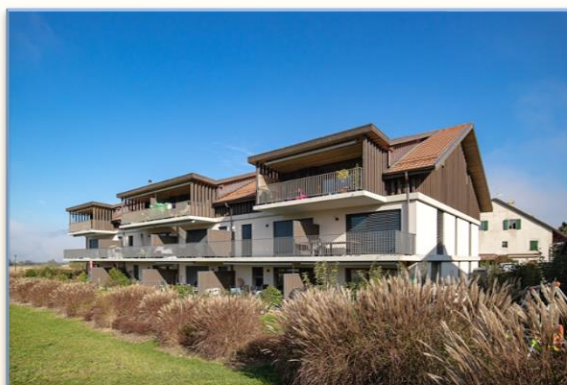
Projet de construction de 3 immeubles à Soral Métrés - Soumissions Année 2017
